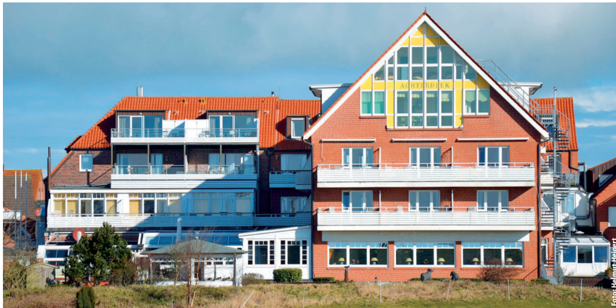
Unter einem Dach: Nicht nur den Gästen, sondern auch den Mitarbeitern des Hotels Achterdiek steht Wohnraum zur Verfügung.
